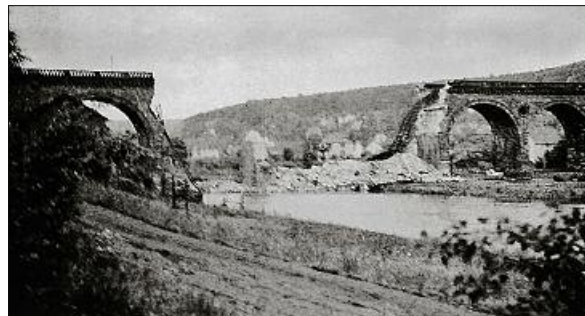
Noch kurz vor Ende des Zweiten Weltkriegs wurde die 90 Jahre alte Brücke von der Wehrmacht gesprengt, um so die vorrückenden Amerikaner aufzuhalten – was sich als sinnlos erwies.
